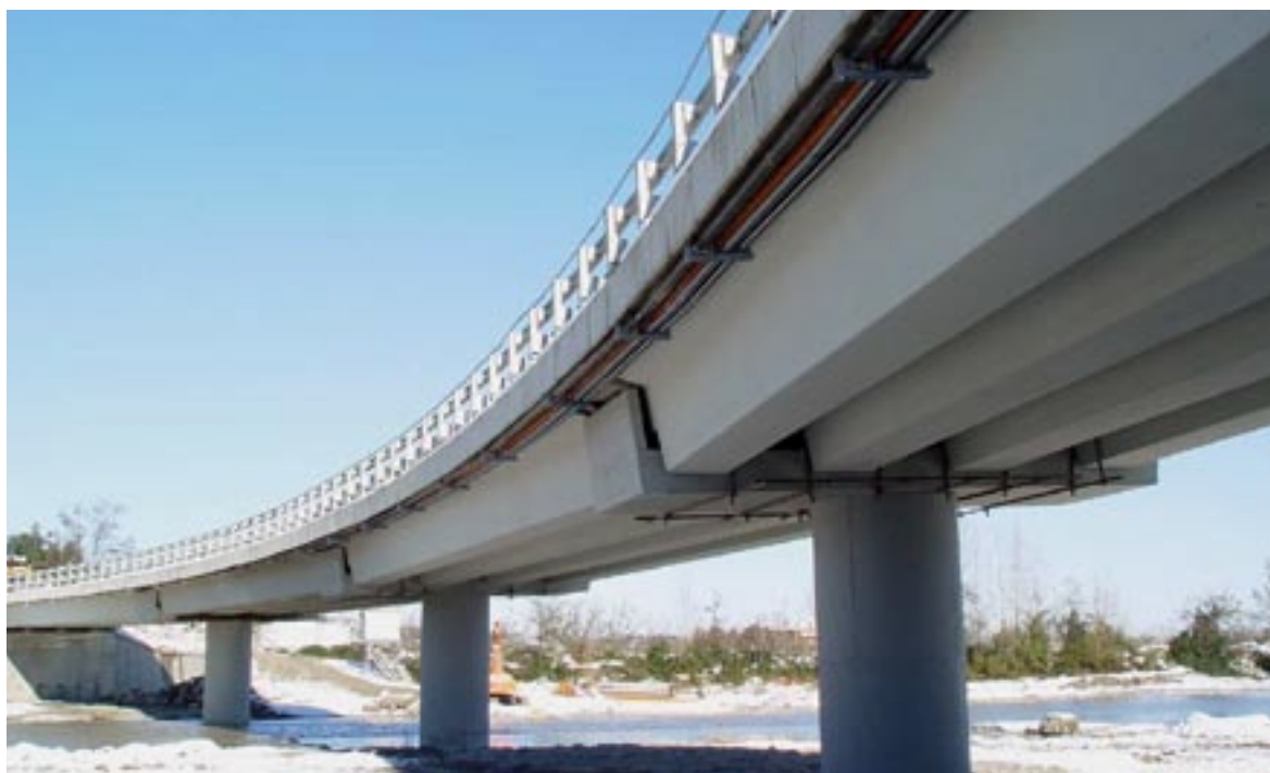
Il nuovo ponte sul Panaro a Marano
